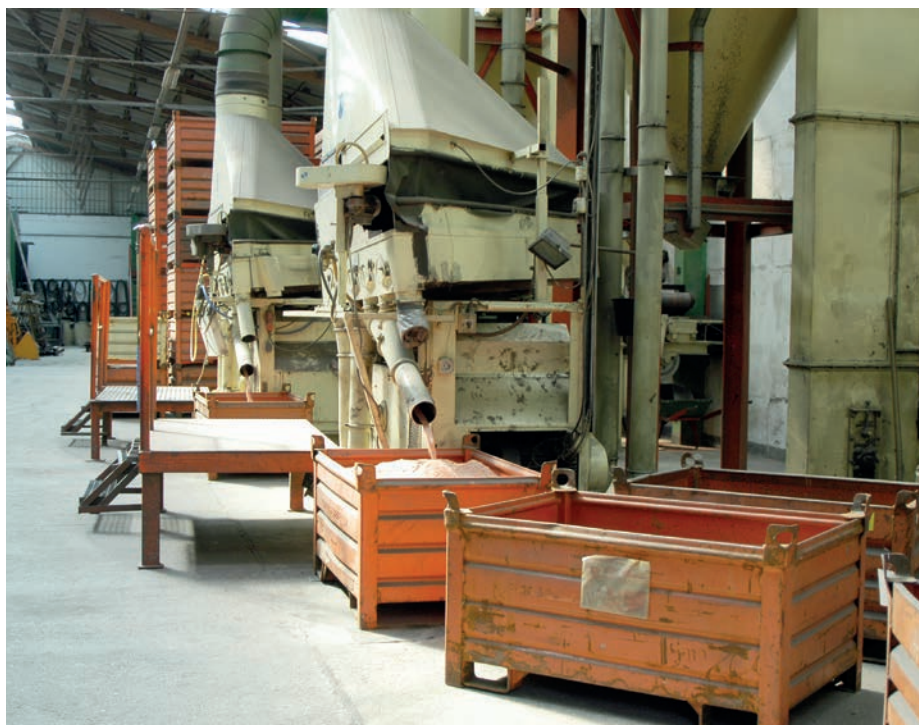
In einem mehrstufigen Wiederaufbereitungsprozess werden aus Kabelabfall wertvolle Rohstoffe gewonnen.
