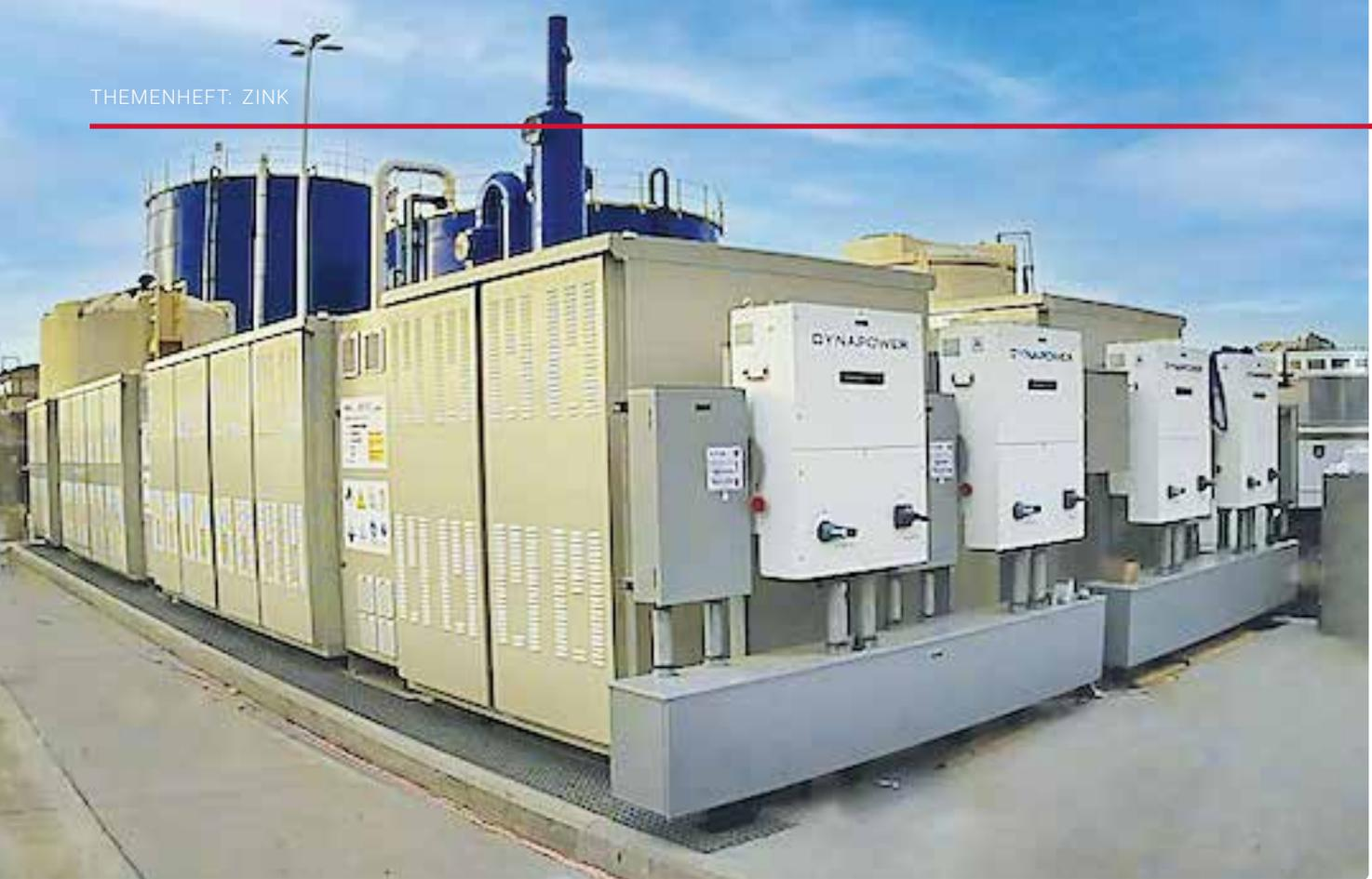
Zwei MWh Redflow-Zink-Brom-Flow-Batterie-Energiespeicher und Dynapower-Wechselrichter in der Anaergia-Biogasanlage, Kalifornien
